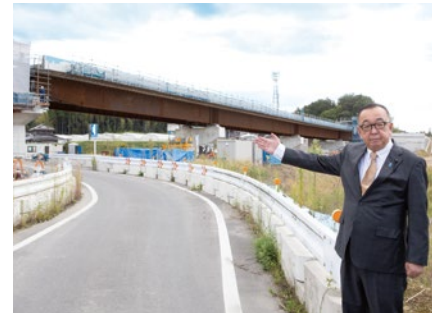
▲工事が進む山手幹線
