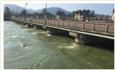
全閉された瀬田川洗堰
