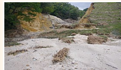
ため池堤体決壊
